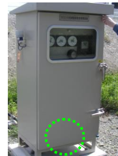
電力会社 駐車場電源盤
