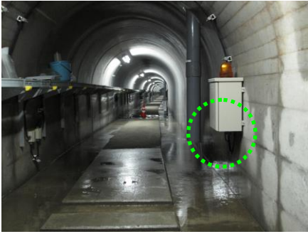
非常用電話(水力発電所)
