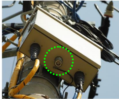
電柱の制御盤
