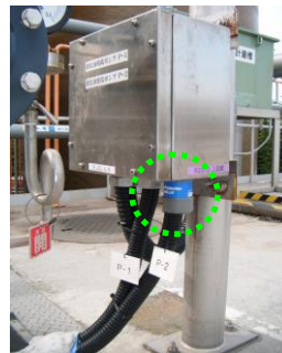
化学薬品工場 浄水装置中継箱
