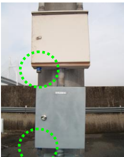
埠頭 照明分電盤
