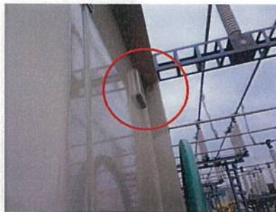
白相通気口閉鎖状況:2箇所(シリコンにて閉鎖実施)
